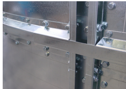
Versteifungsring und Ringverbinder
