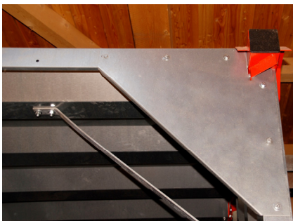
Eckstrebe und Diagonalblech
