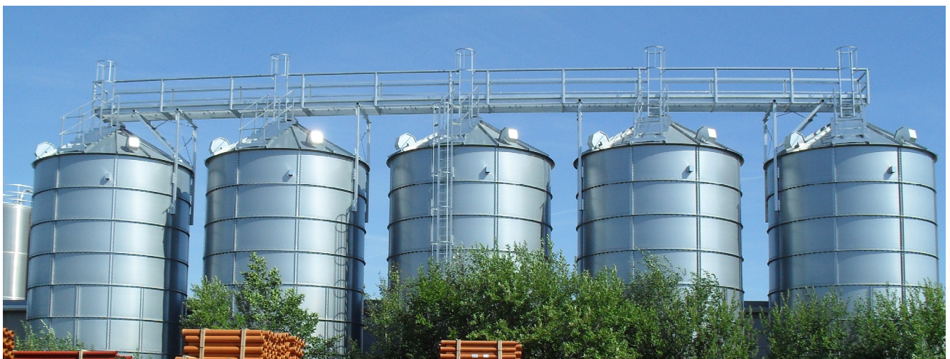
Siloanlage mit 5 Stück Glattwand Außensilos Typ GWSA 6,0/13
