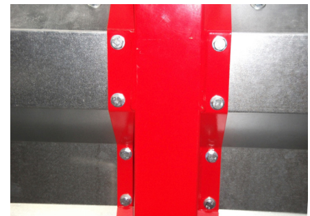
Verschraubung Siloplatte mit Silostütze
