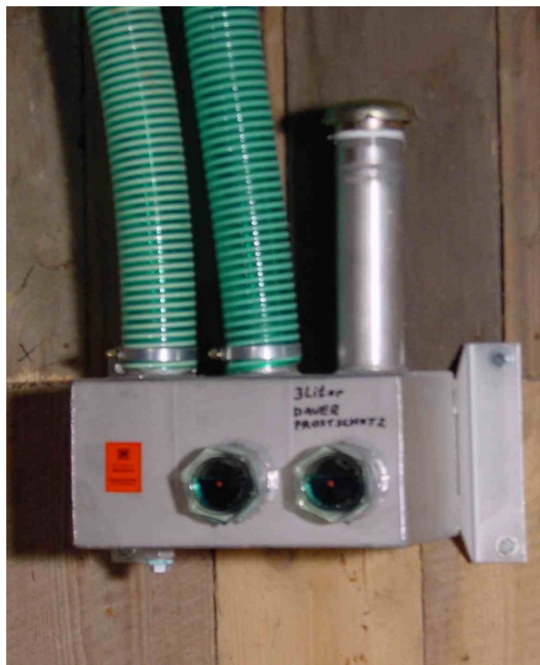
3-Kammer Sicherheitsventil zur Druckbegrenzung bei Über- und Unterdruck
