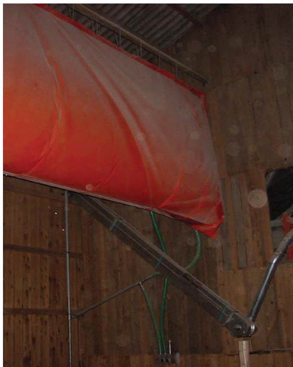
Ausgleichsballon aus säure- und lichtbeständigem Material als Gasreservebehälter und zum Druckausgleich
