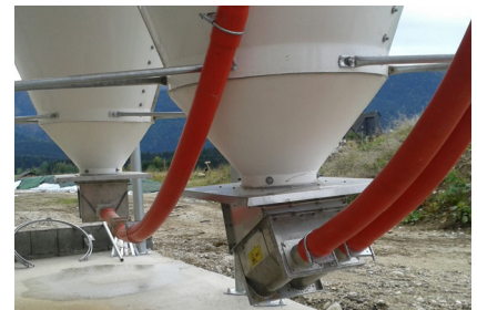
Glasfibersilo mit Doppel-Einlaufkasten
