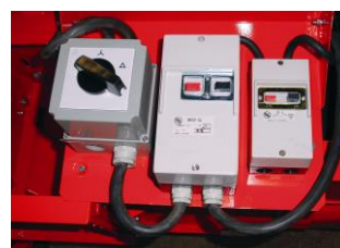
Elektroausrüstung komplett montiert
